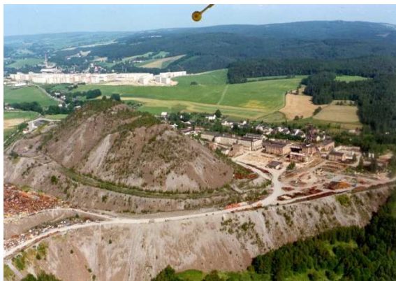
Waste dump # 366 in 1994 and 2004 Courtesy: Wismut GmbH
